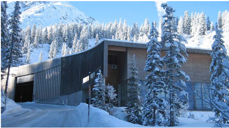
Das Heizwerk in Lech am Arlberg ist eines von 125 Biomasse-Heizwerken in Vorarlberg, die für einen Anteil biogener Fernwärme von 92 % sorgen.
