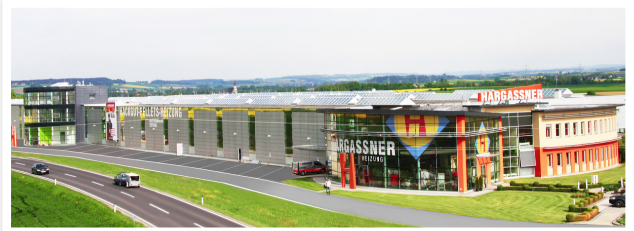
Seit 28 Jahren produziert Hargassner Heizanlagen im Biomasse-Heizwerkzentrum in Weng.
